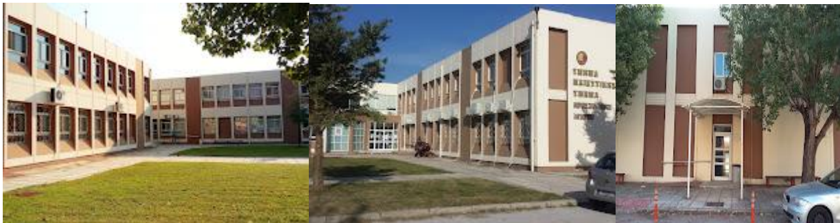
Εικόνα 1. Όψη του κτιρίου του Τμήματος
